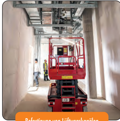
Befestigung von Lüftungskanälen Fastening ventilation ducts
