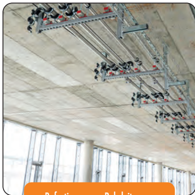
Befestigung von Rohrleitungen Fastening piping
